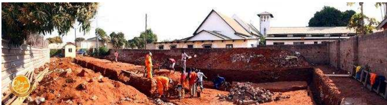
Lavori di costruzione della struttura ricettiva di Olga's: molti studenti del centro di formazione professionale YCTC hanno svolto il periodo di stage in cantiere
